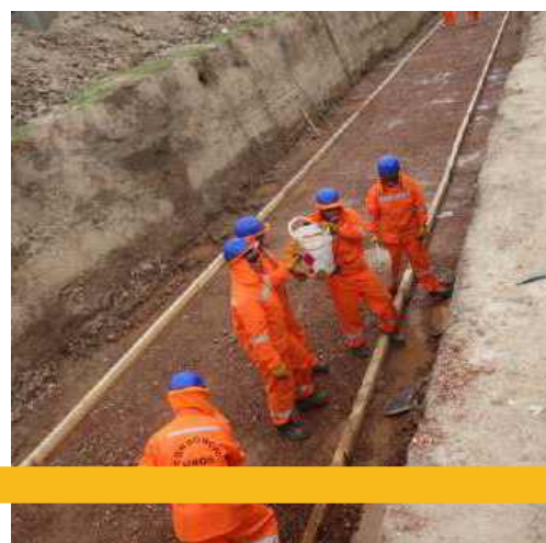
EXCAVACIÓN Y NIVELACIÓN CON MATERIAL FILTRANTE PARA CANAL DE DRENAJE PLUVIAL DE JULIACA
