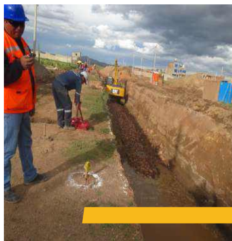
EXCAVACIÓN Y NIVELACIÓN CON MATERIAL FILTRANTE PARA CANAL DE DRENAJE PLUVIAL DE JULIACA
