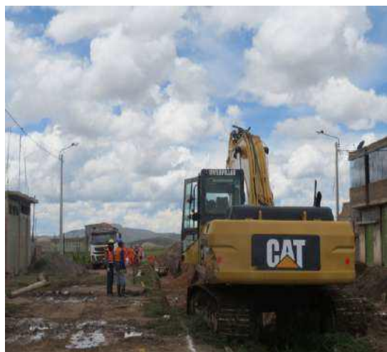
EXCAVACIÓN Y NIVELACIÓN CON MATERIAL FILTRANTE PARA CANAL DE DRENAJE PLUVIAL DE JULIACA
